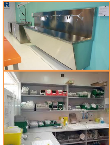
imagen 12, Lavabos y Depósito de equipos
